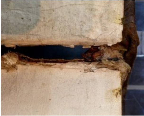
Imagen 20. Fotografía de detalle donde se observa el el enlace de las almas a la tapa.
