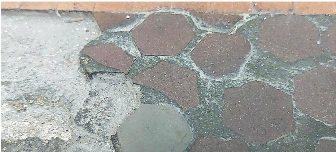
ILUSTRACIÓN 5. ABRASIÓN DE LA SUPERFICIE DE LAS TESELAS, SE ENFATIZA HACIA LOS BORDES
