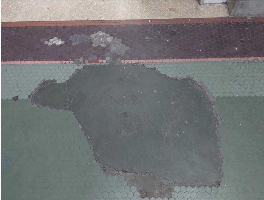
ILUSTRACIÓN 3. EMPARCHADO CON MORTERO CEMENTICIO COLOREADO
