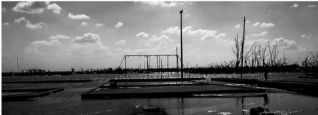
Fig. 21: objeto 10. Vista de la plaza de la ciudad de Epecuén aun algo inundada. Foto propia, 2017
