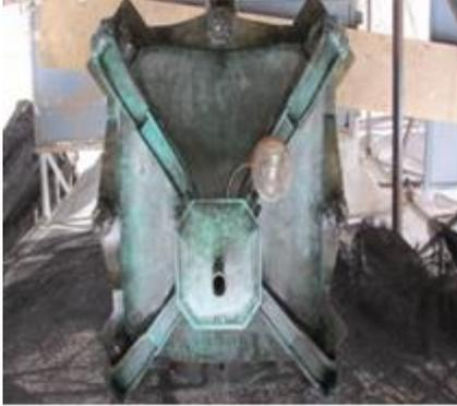
**Imagen N°2:** Farol estación Mitre con patina producto de la corrosión atmosférica.
