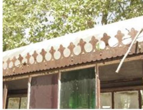
**Imagen N°3:** Reja con corrosión uniforme sobre su superficie.
